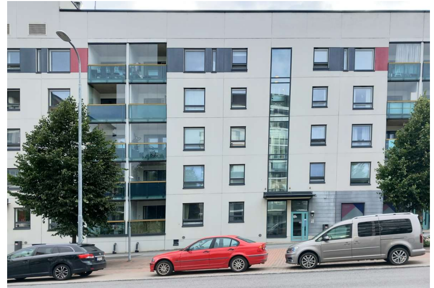
Valkoinen betonielementtijulkisivu sisäänvedetyillä parvekkeilla. Nauha-aihetta tehosteena ylimmän kerroksen ikkunoissa. Kuva Tampereen kaupunki.
