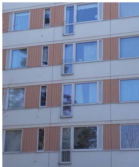
Vasemmalla sisäänvedettyjä, oikealla ranskalaisia parvekkeita Ruotulan torneista. Kuvat Tampereen kaupunki.
